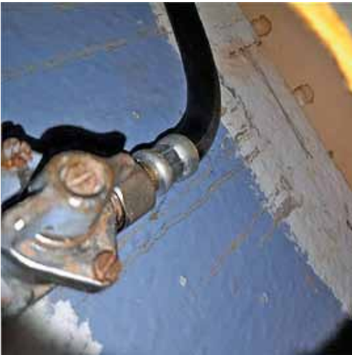
▲ Zwarte rubberen gasaansluiting
